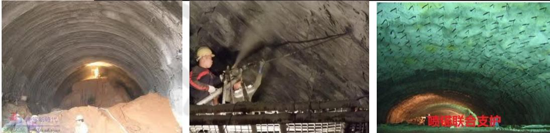
1) 喷混凝土具备以下几方面的作用：
