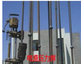
钢筋焊接示意图
