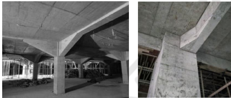
图 5.1.4 水平加腋截面注写示意
